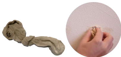
ストッキング ひび割れ補修に使用 ※ご自身で準備してください
