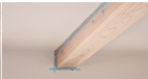
入隅用のコテで入れた珪藻土を押さえます ※隙間に珪藻土が入り込むよう、しっかり押さえて下さい
