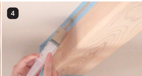
注射器で隙間に 珪藻土を入れ込みます
