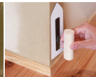
元々の壁と、新しく塗った珪藻土の境目に凹凸が出来るので プラスチックコテで、凹凸部分を押さえて馴染ませます
