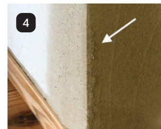
元々の壁と、新しく塗った珪藻土の境目に凹凸が出来るので プラスチックコテで、凹凸部分を押さえて馴染ませます
