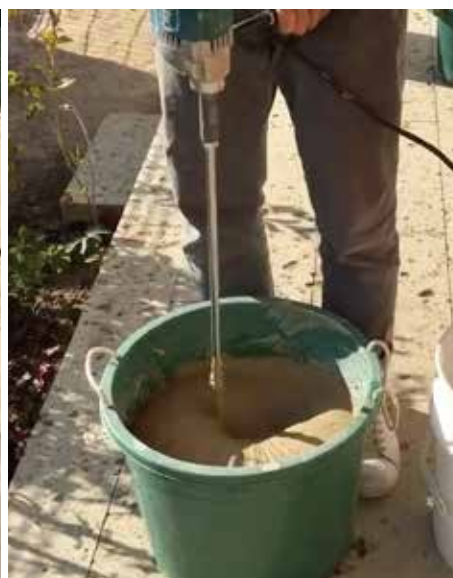
柄杓(400cc)2杯加水して、かくはん機で約1分練って完成
